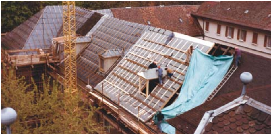
La bibliothèque a été aménagée sous les combles des ailes ouest et nord de l'Abbaye. Le chantier, commencé en automne 1984 a permis la réfection des toitures.
